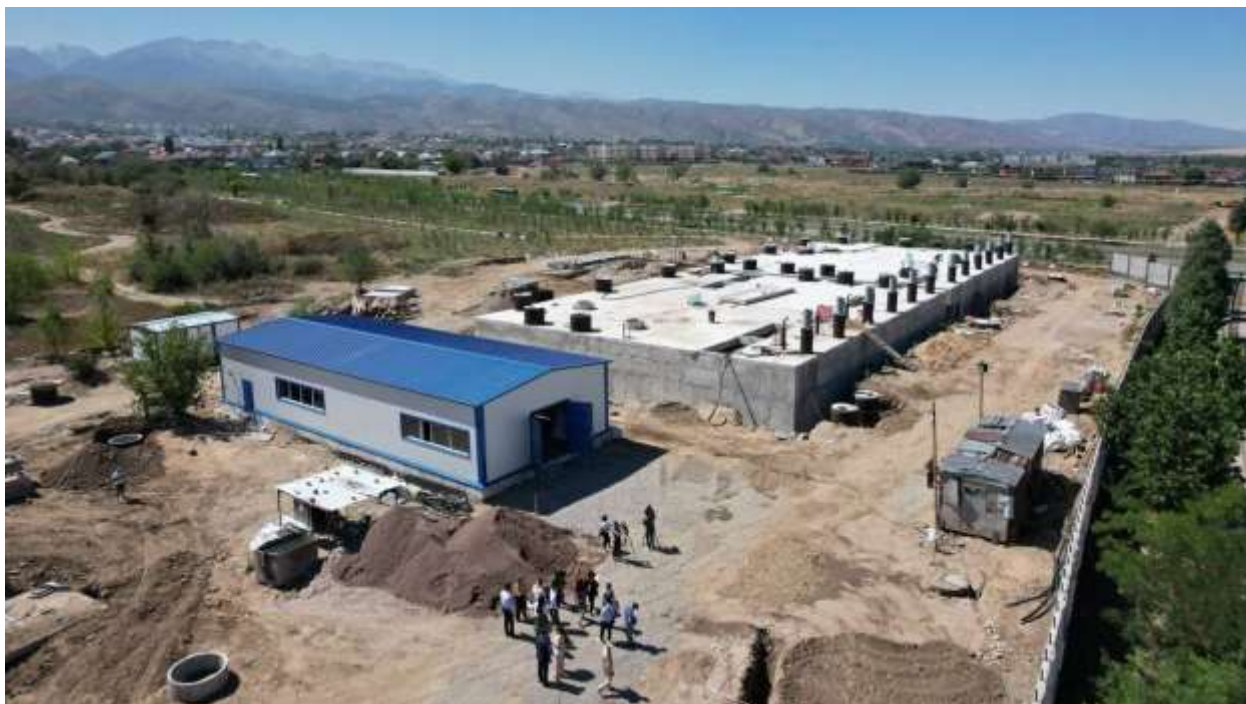
Рисунок 6 - Строительство фильтровальной станции «Акса́й» для водоснабжения Наурызбайского района г. Алматы
